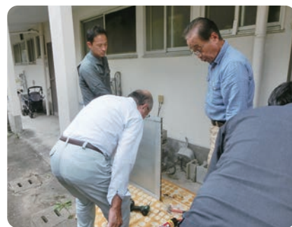
▲サッシの修理
